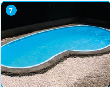
7 Asientos de brocales Coping stone placing
