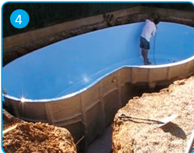
4 Puesta a nivel Levelling
