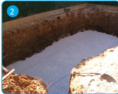
2 Preparación del terreno Ground preparing
