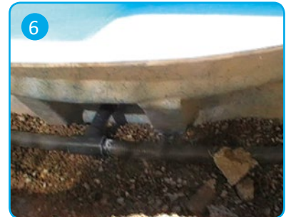
6 Conducciones periféricas Peripheral pipes
