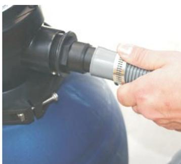
12 CONECTE EL OTRO LADO DEL MANGUITO (7) AL RACORD DE ENTRADA DE LA VALVULA Y APRETAR FIRMEMENTE LA BRIDA.
